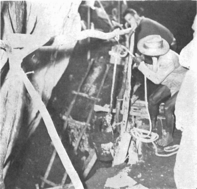
Pl. 3 Halage des matériaux hors du puits de Is 1 Son 2 (Cl. Chabouis)
