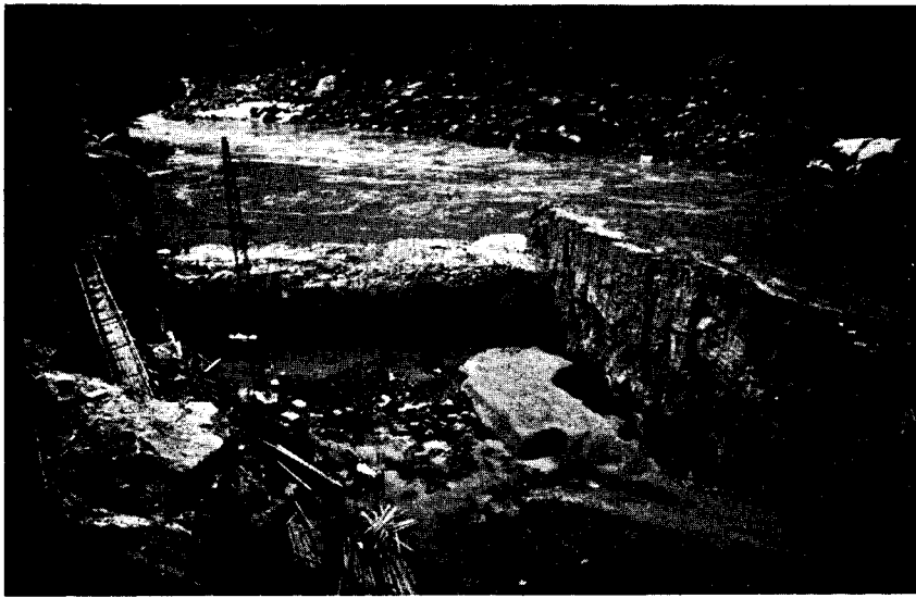
Les travaux du batardeau amont (Photo de l'auteur).
