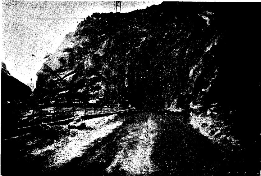
Percement de l'accès à la centrale souterraine (Photo de l'auteur).
