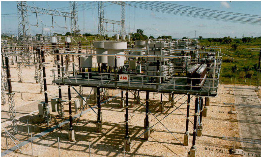
Figure 3 : Un condensateur série commandée par thyristors
