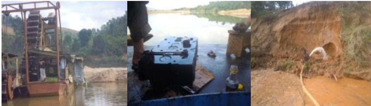
Photos 2-3-4. Les types des engins mécaniques pour les travaux sous l'eau
