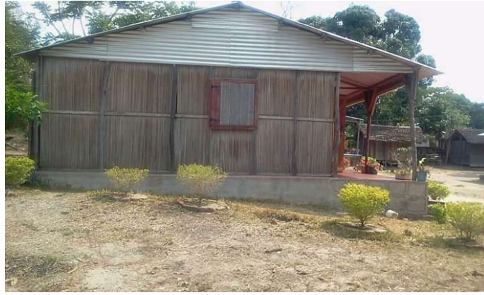
Figure 3 : Mur en falafa
