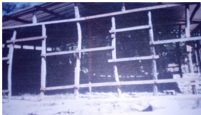
Figure 2 : Ossature d'une maison en falafa avec la charpente et couverture
