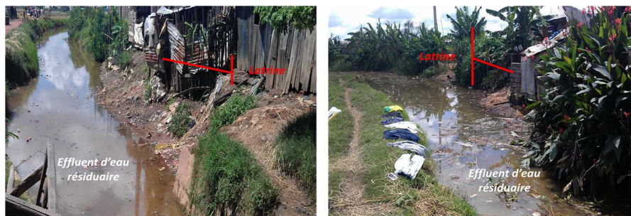
Figure 5- Débordement des latrines dans le canal de collecte des eaux usées à Imamba Centre et Poteau Vy
