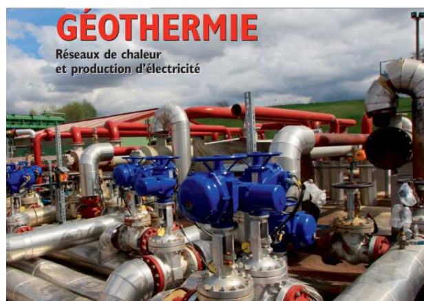
Figure 01 : Réseaux de traitement de vapeur géothermique
