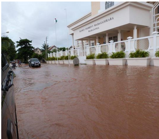
Figure 16 : Inondation devant la Banque Centrale de Mahajanga
