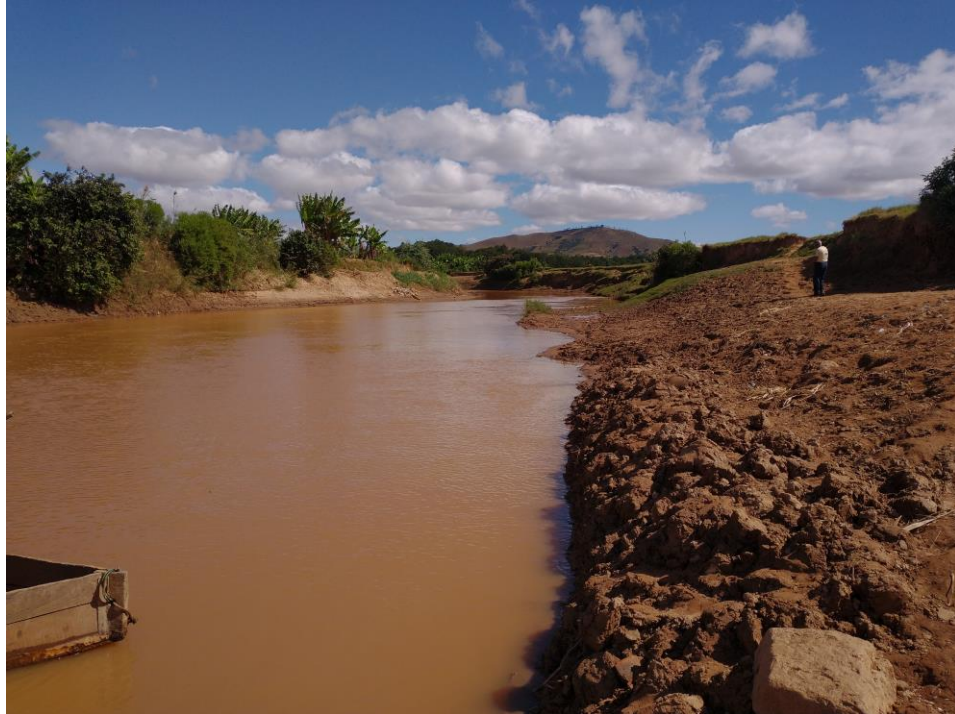
Photo3 : Effets de l'érosion latérale sur la hauteur des berges, ici 4 à 5mètres (cliché de l'auteur 2024)
