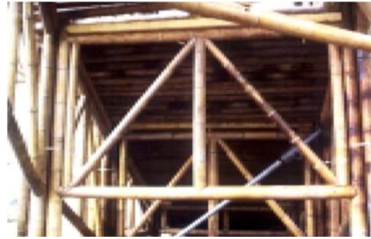
Figure 08 : Représentation de la poutre en bambou
