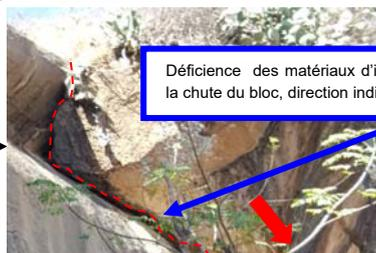
Déficiences des matériaux d'incrustation pouvant entraîner la chute du bloc, direction indiquée par la flèche rouge
