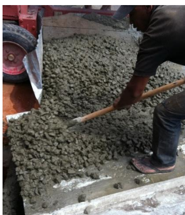
Photo 1 : Mélange liquide et mal proportionné Photo 2 : Béton cassé
