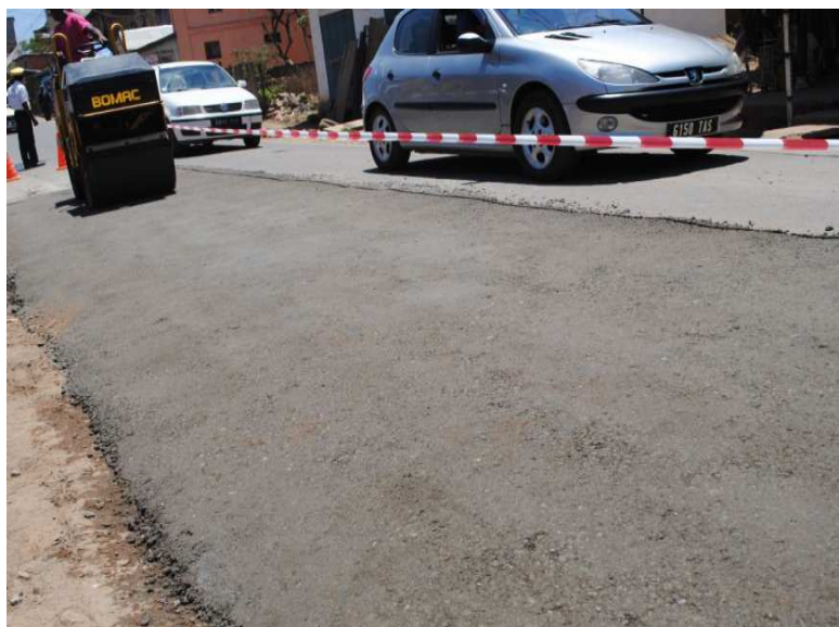
Photo 3- Compactage de la couche
