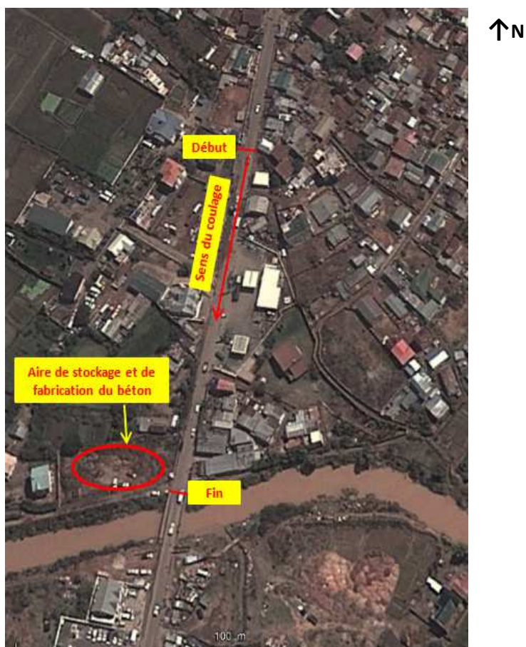
Photo 1- Vue d'ensemble du chantier
