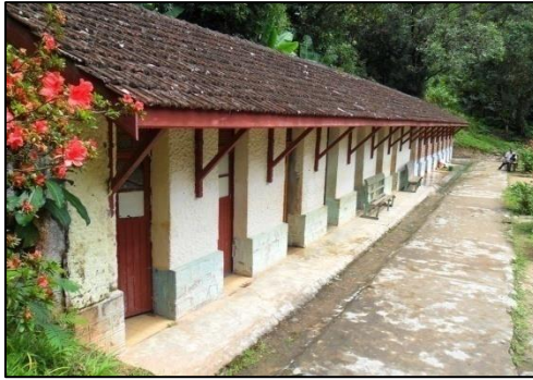
Figure 10 : Bâtiment pour bain thermal
